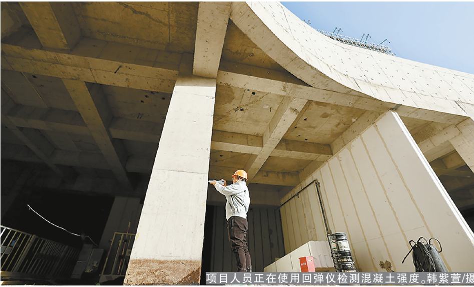
项目人员正在使用回弹仪检测混凝土强度。韩紫萱/摄
