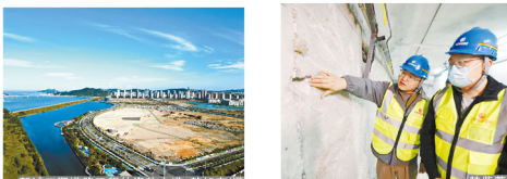
洞头一期新建道路的道路工程顺利完工
