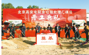
北京高安屯厨余垃圾处理厂项目开工
