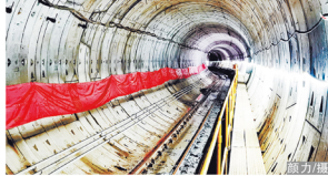
3号线03标星体区间右线盾构贯通
