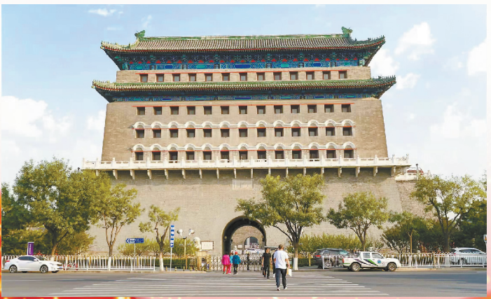
六建集团精心完成正阳门箭楼修缮工程,让这座北京中轴线上的标志性建筑焕发新的活力。
