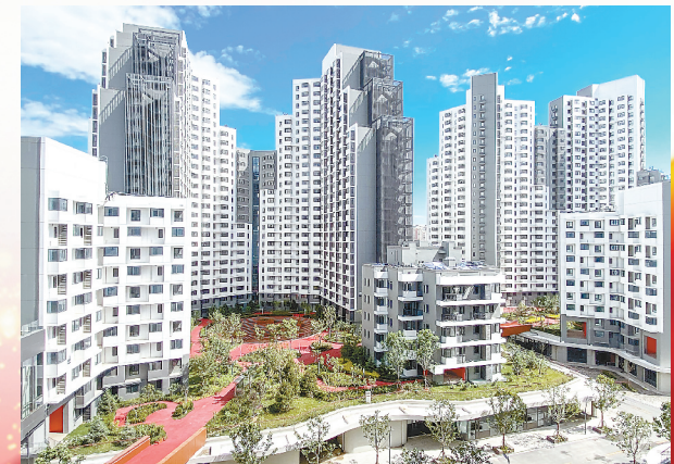
百子湾公租房被称为“最美公租房”,由六建集团匠心建设,荣获中国土木工程詹天佑奖。
