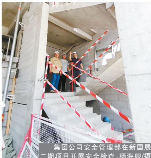
集团公司安全管理部在新国展二期项目开展安全检查。杨海舰/摄
