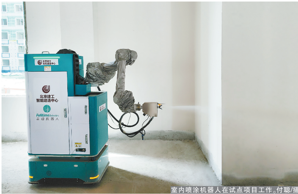
室内喷涂机器人在试点项目工作。付聪/摄
