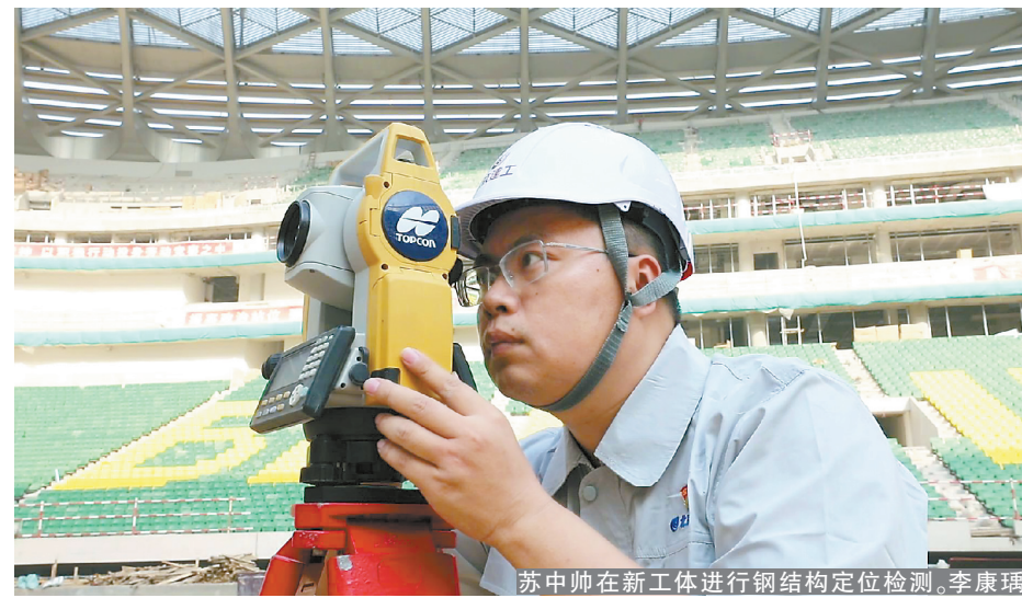
苏中帅在新工体进行钢结构定位检测。李康瑞/摄
