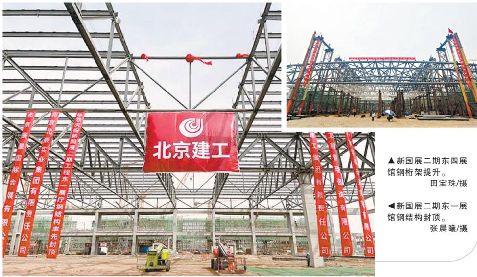
日前,随着最后一根钢梁稳稳升空、吊装到位,新国展二期项目东一展馆在9个展馆中率先完成钢结构封顶,比计划提前30天。与此同时,东四展馆钢结构主桁架实现首次提升到位,标志着新国展二期项目钢结构施工迈入了新的阶段。
