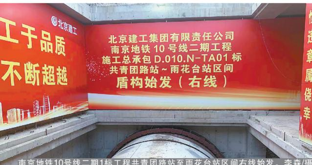
近日,随着盾构机刀盘缓慢转动、开始破土,由集团承建的南京地铁10号线二期1标工程共青团路站至雨花台站区间右线顺利始发,未来将完成309.95米的区间盾构掘进任务。
