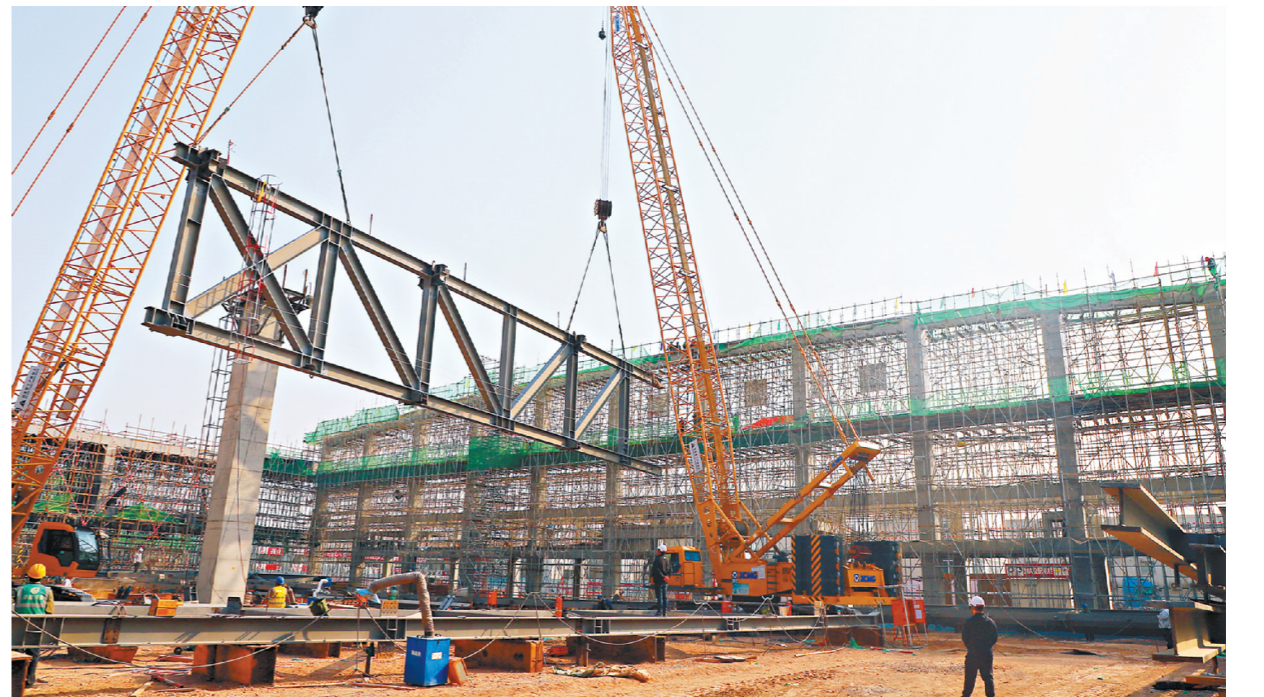
3月19日，随着最后一方混凝土浇筑完成，新国展二期项目东1展馆在项目总共9个展馆中率先实现结构封顶。据悉，项目地上混凝土结构施工预计于4月底全部完成。图为东1展馆在吊装钢桁架。张晨曦/摄影报道
