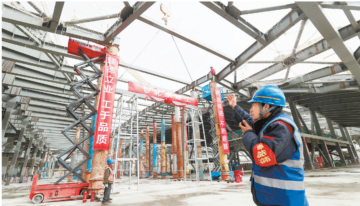
3月22日，四建公司承建的中关村论坛永久会址主会场项目最后一根结构钢梁稳稳升空、吊装就位，这座备受瞩目的首都“科技会客厅”如期实现钢结构封顶，向着今年8月底整体竣工的目标迈出关键一步。祖戈/摄影报道
