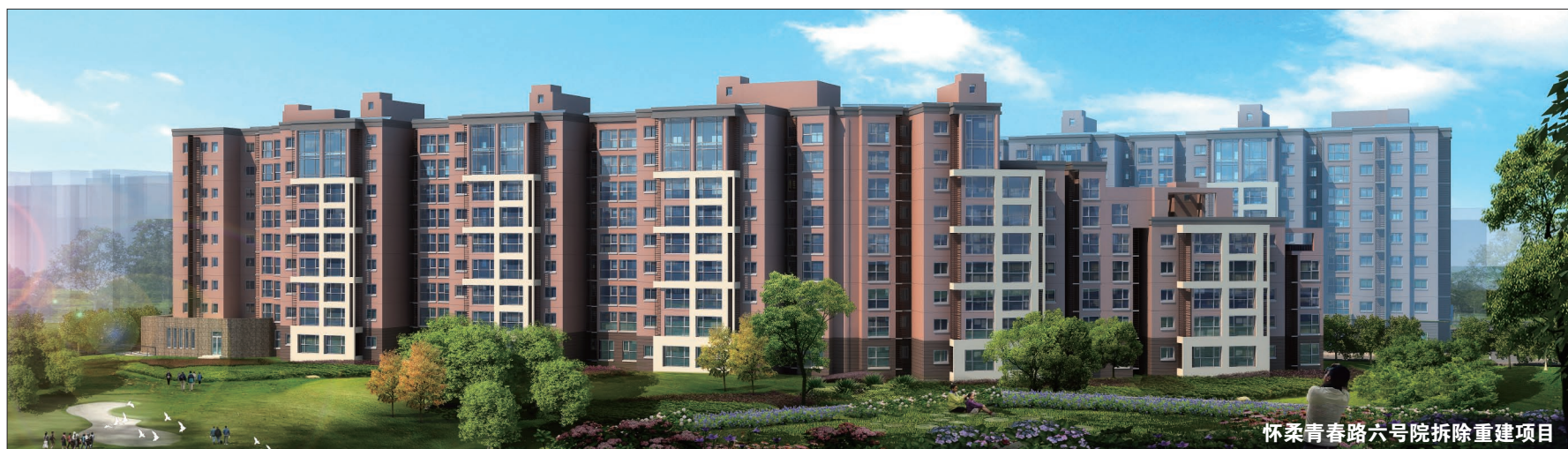
衢州高铁新城姜家山大塘头安置房项目
