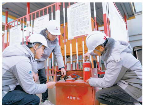
建筑工程总承包部通州六小村安置房项目开展安全巡检。王帅/摄
