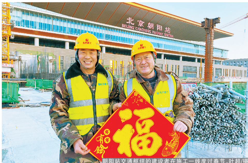
朝阳站交通枢纽的建设者在施工一线度过春节。叶超/摄
