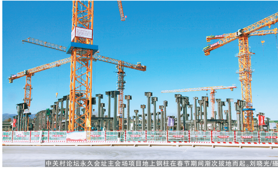
中关村论坛永久会址主会场项目地上钢结构在春节期间渐次拔地而起。刘曙光/摄
