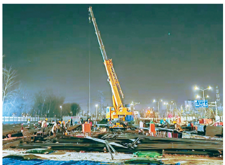
城乡集团环球影城北综合交通枢纽春节期间坚持施工。周玉龙/摄
