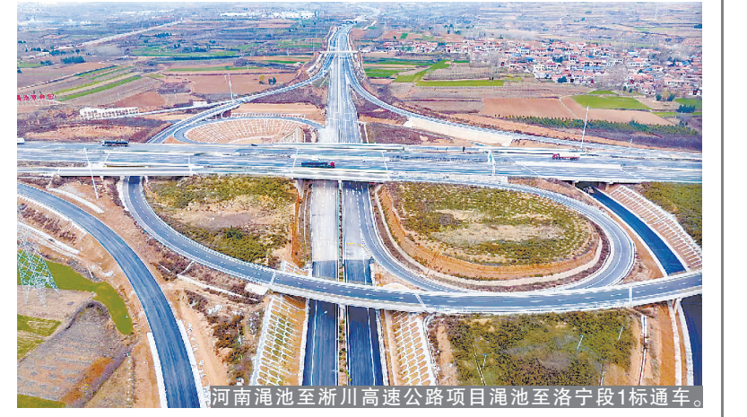
河南澠池至浙川高速公路项目澠池至洛宁段1标通车。
