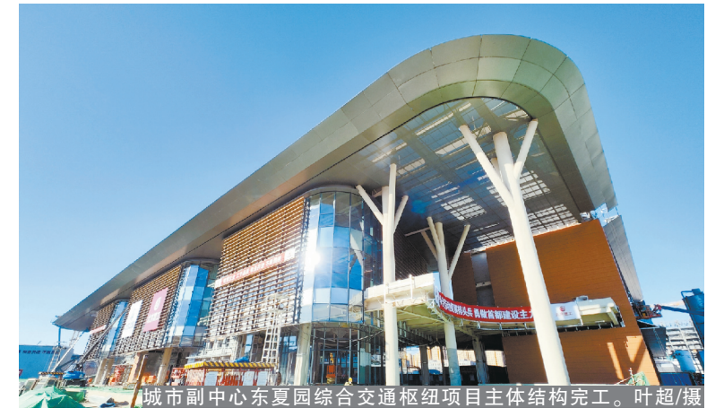
城市副中心东夏园综合交通枢纽项目主体结构完工。叶超/摄
