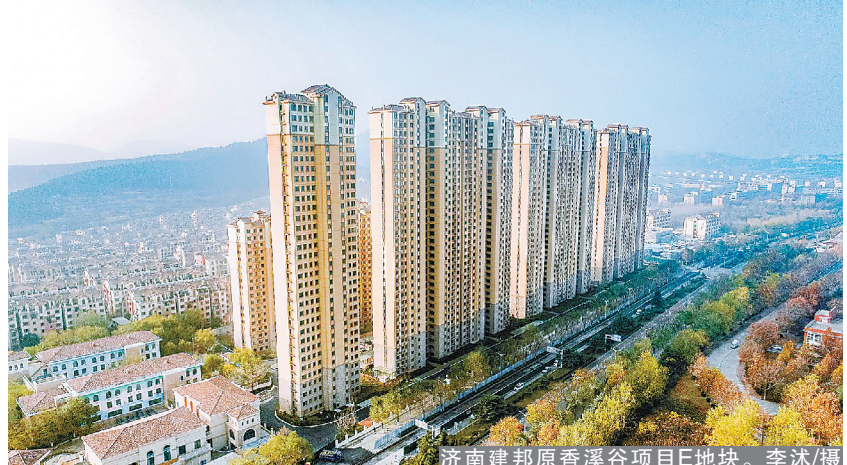
济南建邦原香溪谷项目E地块。李沐/摄
