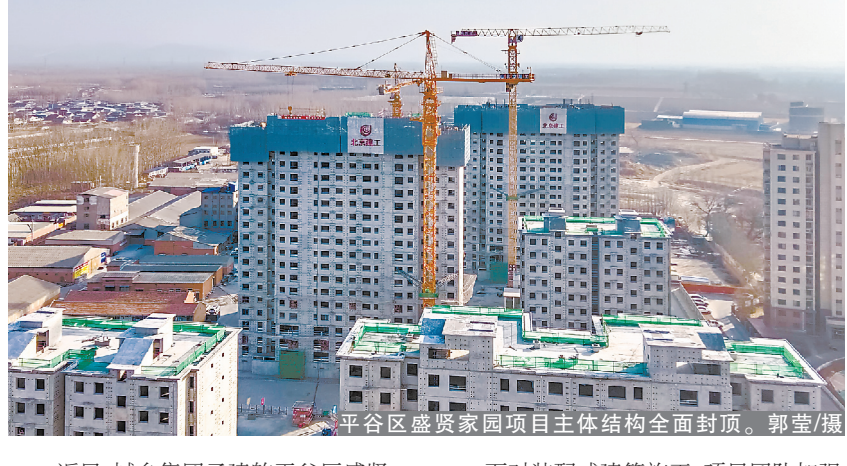
平谷区盛贤家园项目主体结构全面封顶。郭莹/摄
