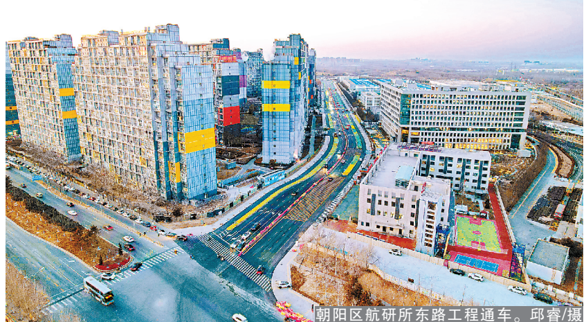
朝阳区航研所东路工程通车。邱睿/摄
