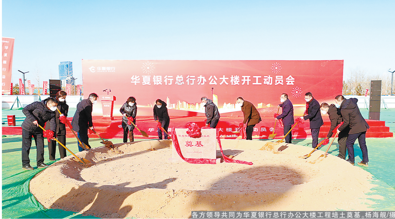
各方领导共同为华夏银行总行办公大楼工程培土奠基。杨海舰/摄
