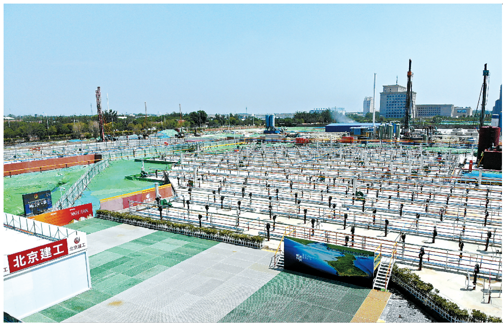
芜湖新兴铸管弋江老厂区5号地块土壤修复项目
