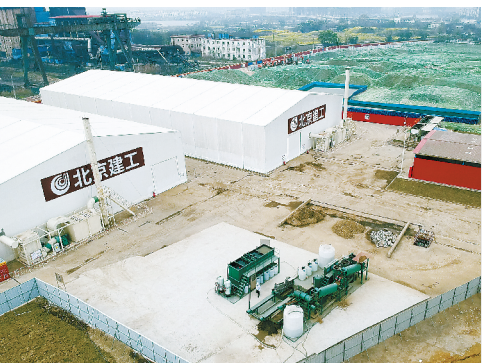
芜湖新兴铸管弋江老厂区5号地块土壤修复项目
