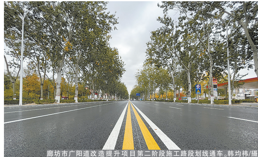
廊坊市广阳道改造提升项目第二阶段施工路段划线通车。韩均伟/摄
