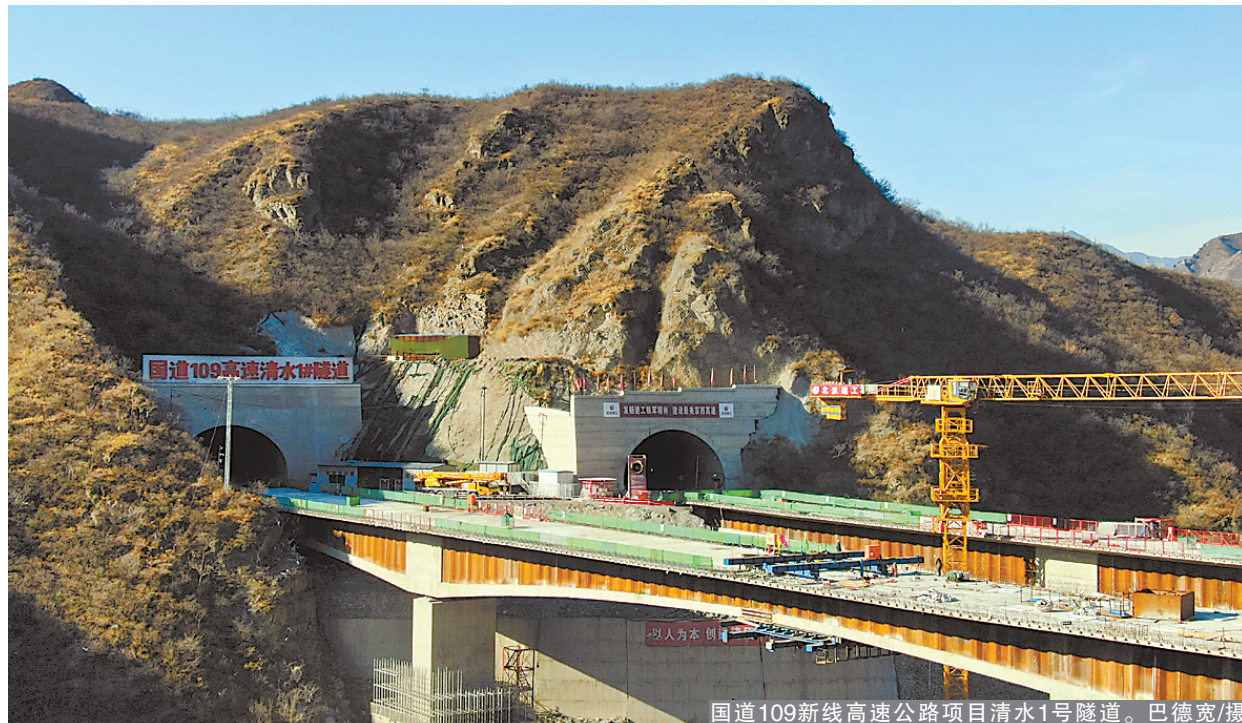
国道109新线高速公路项目清水1号隧道。巴德宽/摄
