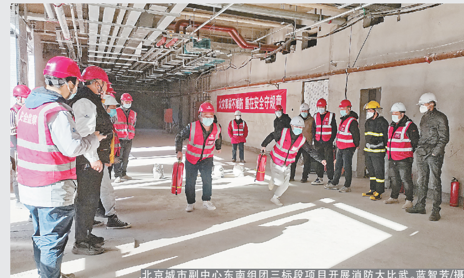
北京城市副中心东南组团三标段项目开展消防大比武。蓝智芳/摄
