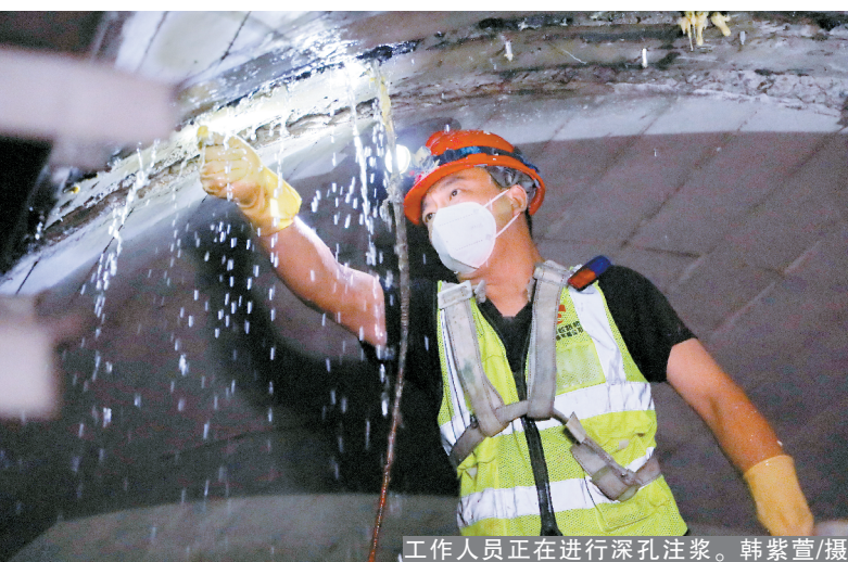
工作人员正在进行深孔注浆。韩紫萱/摄
