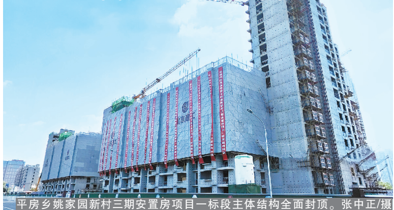
平房乡姚家园新村三期安置房项目一标段主体结构全面封顶。张中正/摄
