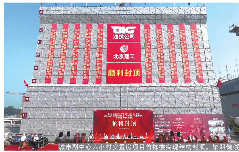
城市副中心六小村安置房项目首栋楼实现结构封顶。毕照健/摄
