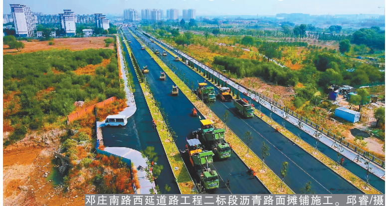
邓庄南路西延道路工程二标段沥青路面摊铺施工。邱睿/摄
