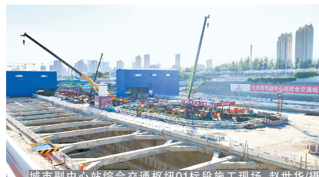
城市副中心站综合交通枢纽01标段施工现场。赵世华/摄
