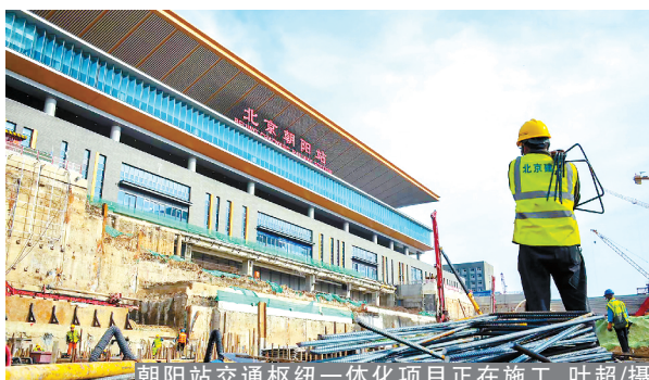
朝阳站交通枢纽一体化项目正在施工。叶超/摄
