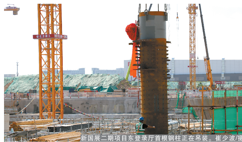
新国展二期项目东登录厅首根钢柱正在吊装。崔少波/摄
