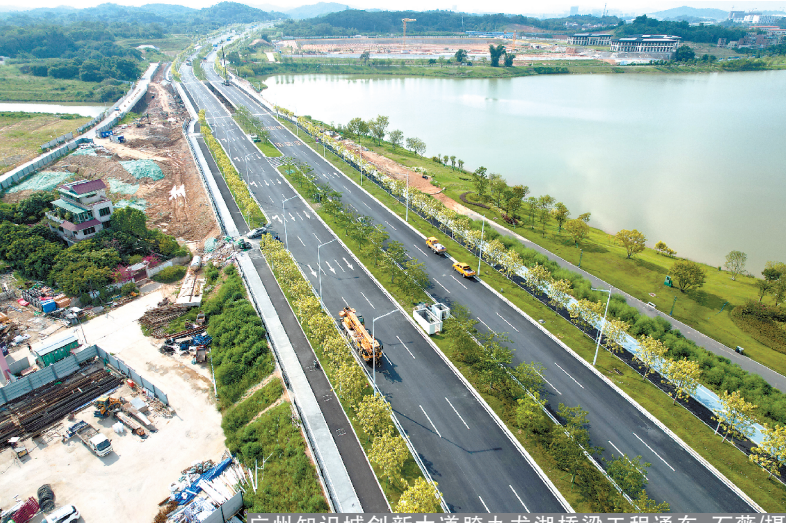
广州知识城创新大道跨九龙湖桥梁工程通车。石薇/摄
