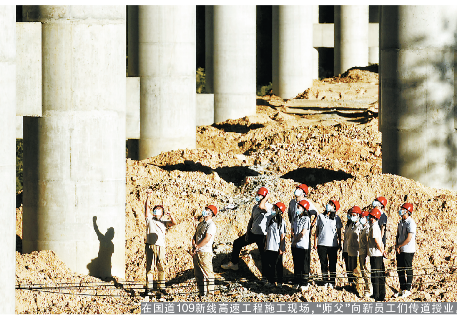
在国道109新线高速工程施工现场,“师父”向新员工们传授技艺。
