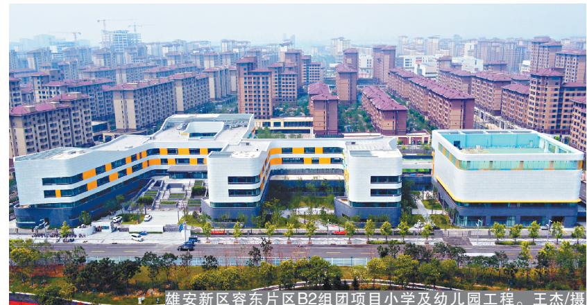
雄安新区容东片区B2组团项目小学及幼儿园工程。王杰/摄
