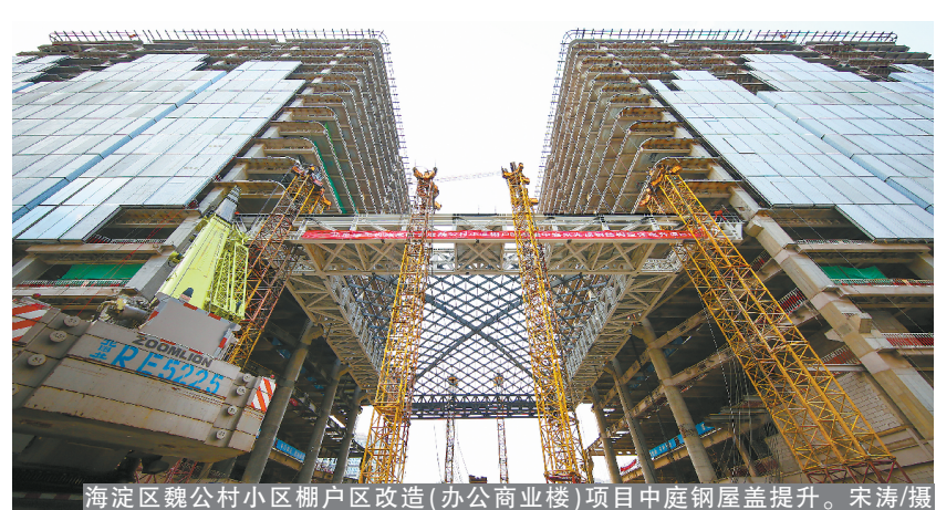
海淀区魏公村小区棚户区改造(办公商业楼)项目中庭钢屋盖提升。宋涛/摄
