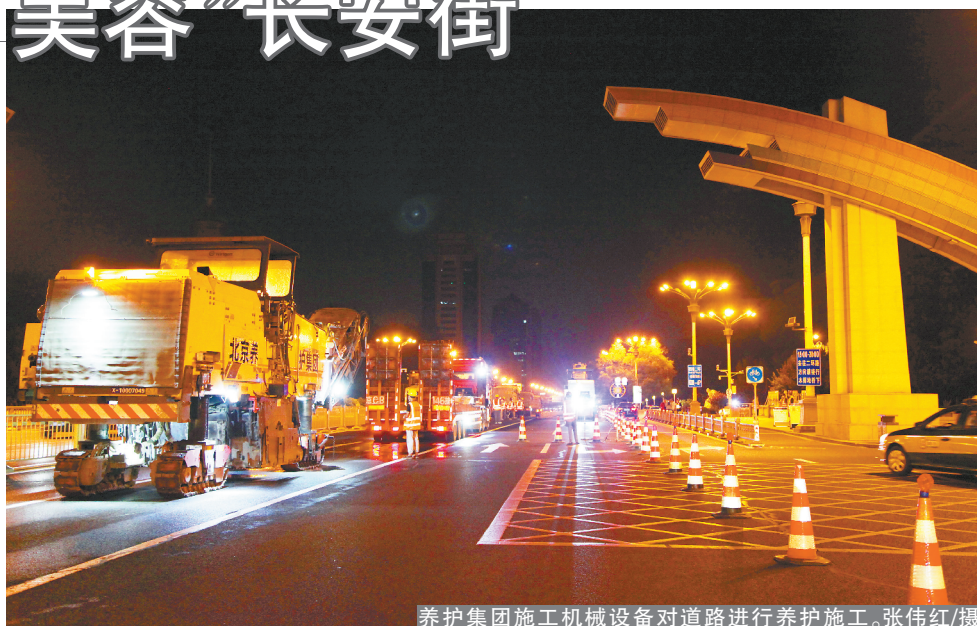
养护集团施工机械设备对道路进行养护施工。张伟红/摄
