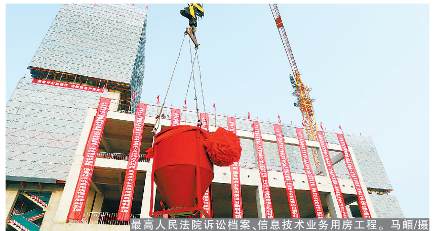
最高人民法院诉讼档案、信息技术业务用房工程。马顺/摄
