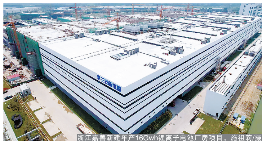
浙江嘉善新建年产16Gwh锂离子电池厂房项目。施祖莉/摄
