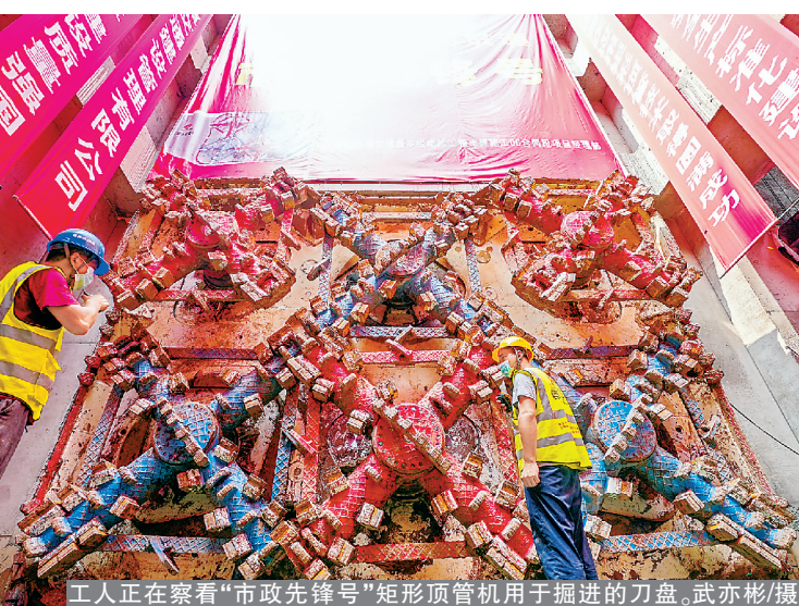
工人正在察看“市政先锋号”矩形顶管机用于掘进的刀盘。武亦彬/摄
