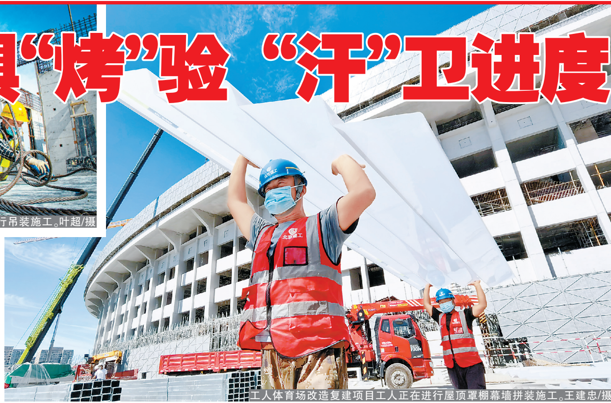
工人体育场改造重建项目工人正在进行屋顶棚幕墙拼装施工。王建忠/摄
