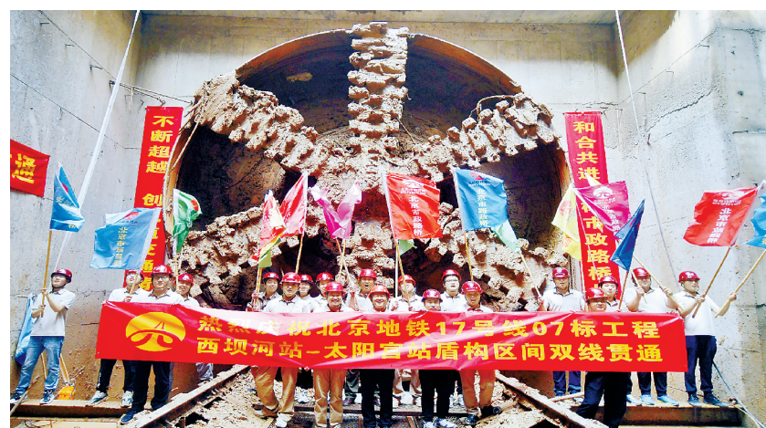
北京地铁17号线07标工程西坝河站至太阳宫站盾构区间双线贯通。于佳/摄
