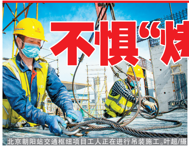
北京朝阳站交通枢纽项目工人正在进行吊装施工。叶超/摄
