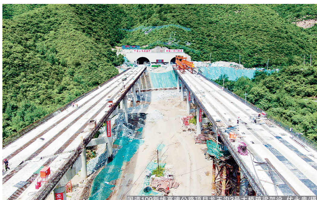
国道109新线高速公路项目龙王沟3号大桥箱梁架设。伏永贵/摄
