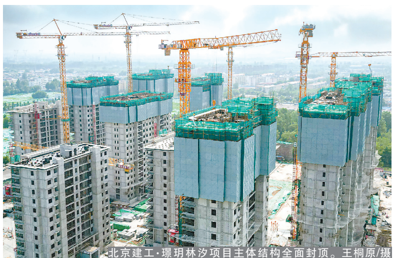
北京建工·璟玥林汐项目主体结构全面封顶。王桐原/摄
