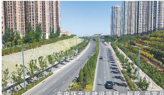
东中环北延建设项目一标段。母富兵/摄
