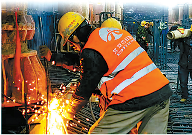
北京地铁昌平线南延11标施工人员正在进行小营西路车站底纵梁钢筋焊接作业。杨文生/摄
