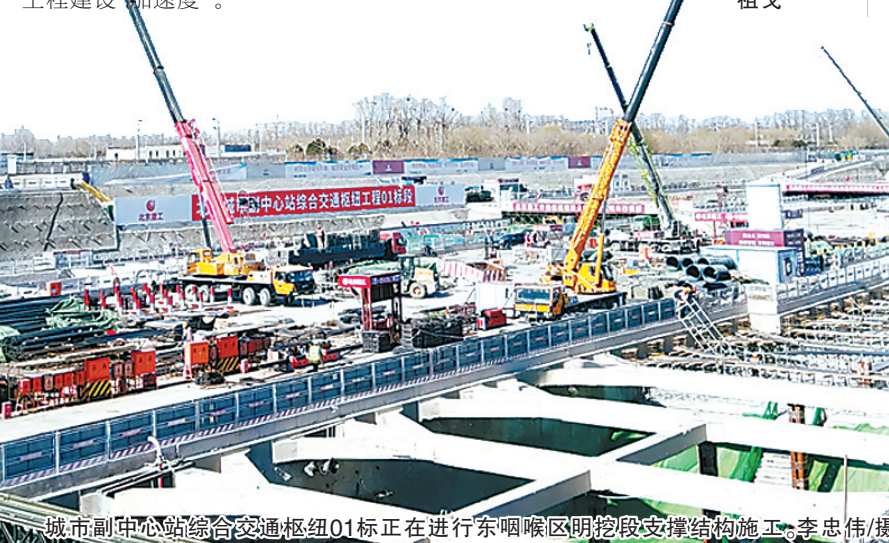
城市副中心站综合交通枢纽01标正在进行东咽喉区明挖段支撑结构施工。李忠伟/摄
