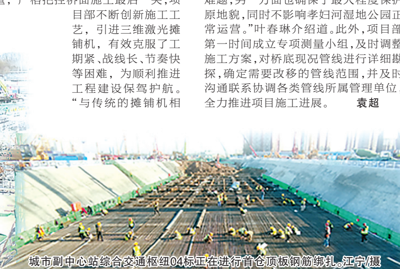
城市副中心站综合交通枢纽04标正在进行首层顶板钢筋绑扎。江宁/摄
