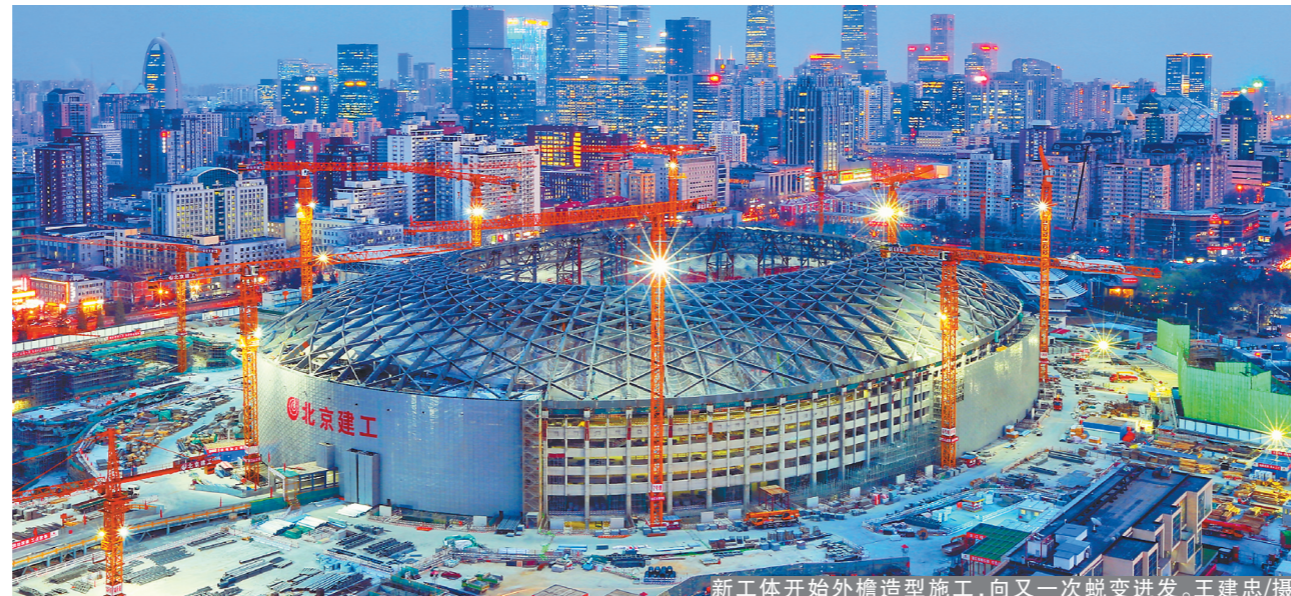
新工体开始外檐造型施工,向又一次蜕变进发。王建忠/摄
