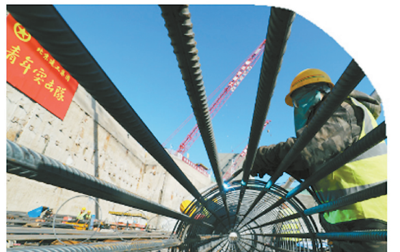
朝阳站交通枢纽项目施工人员正在焊接钢筋笼。祖戈/摄
