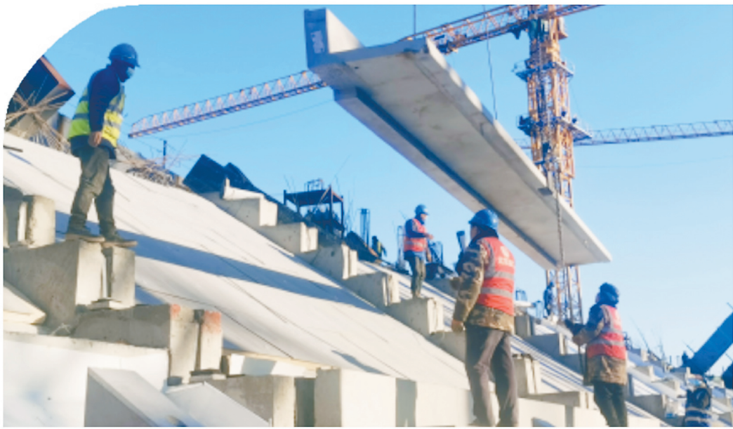
工人体育场改造复建项目施工人员正在安装看台板。刘东旭/摄
