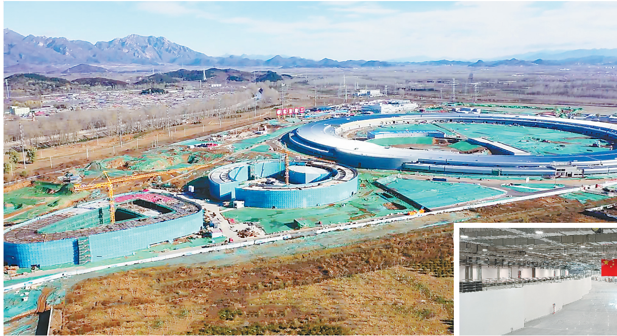
▲高能同步辐射光源项目航拍图。
