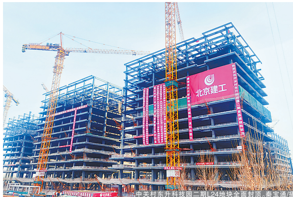
中关村东升科技园二期L24地块全面封顶。秦宝通/摄
