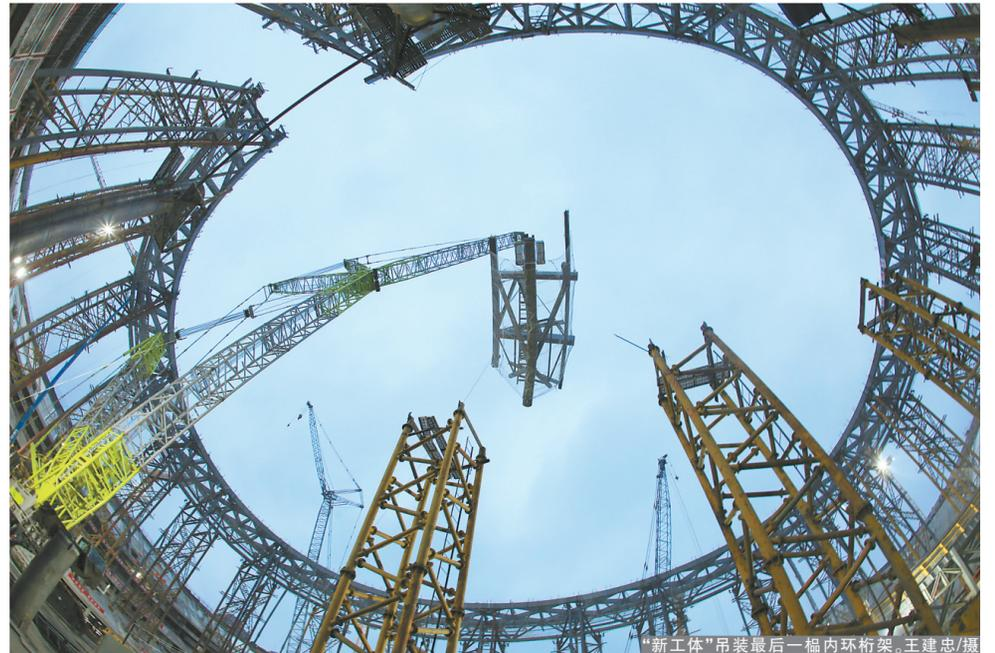
本报讯(通讯员谢孟媛)1月10日上午,北京工人体育场改造复建项目(一期)最后一根内环桁架调试完成,标志着场馆内环桁架顺利实现合拢。内环桁架吊装是工人体育场改造复建项目钢结构施工过
