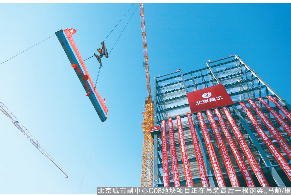
北京城市副中心C08地块项目正在吊装最后一根钢梁。马顺/摄
