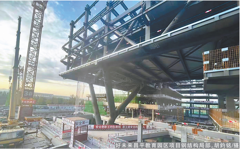
好未来昌平教育园区项目钢结构局部。胡钧铭/摄
