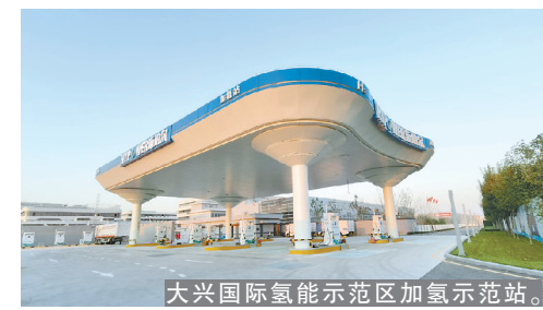
大兴国际氢能示范区加氢示范站。
