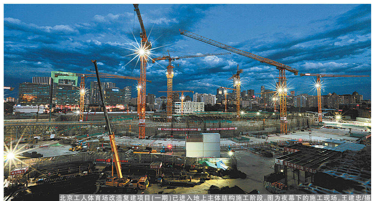
北京工人体育场改造重建项目(一期)已进入地上主体结构施工阶段。图为夜幕下的施工现场。王建忠/摄
