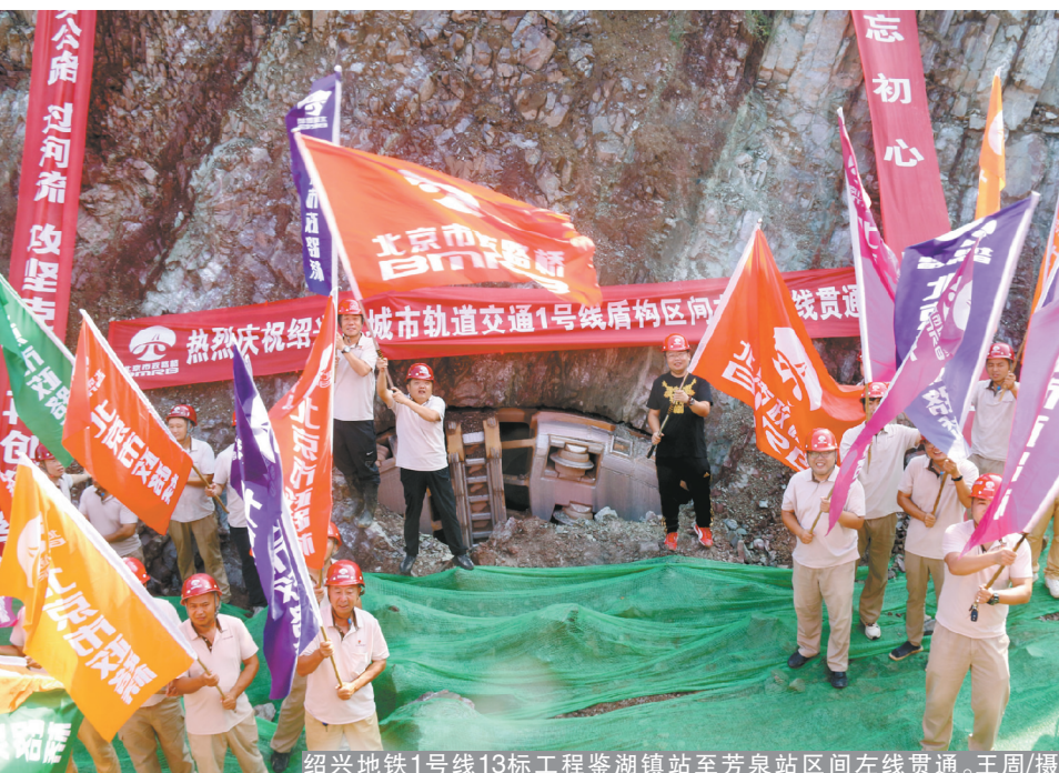
绍兴地铁1号线13标工程鉴湖镇站至芳泉站区间左线贯通。王周/摄
