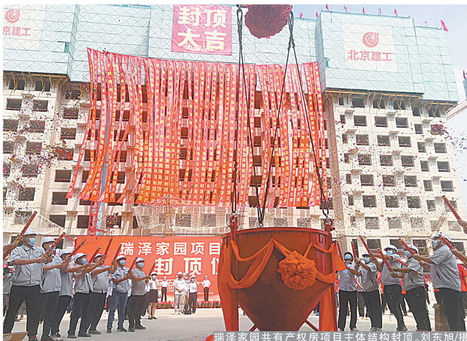
瑞泽家园共有产权房项目主体结构封顶。刘东旭/摄
