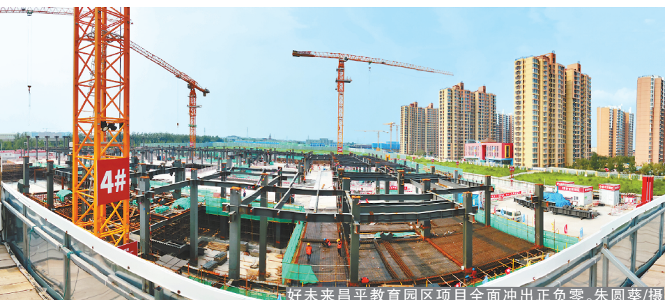
好未来昌平教育园区项目全面冲出正负零。朱国葵/摄
