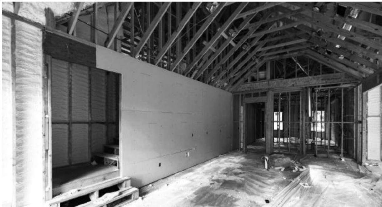
图为亨斯迈聚氨酯建筑保温解决方案的运用现场。
