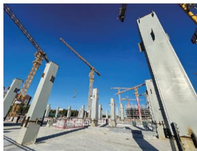
在地下结构施工时,该地块内有372根钢骨柱需要预埋安装。由于场地狭小和钢材价格上涨等困难,为确保材料供给保质保量,实现钢结构安装与土建施工顺利配合,项目攻关小组技术员、质量员赶赴外埠厂家驻场,会同钢结构厂家技术人员,根据设计要求和塔吊使用周期对钢柱进行了深化设计,现场监督钢柱及柱脚锚栓的生产进度、质量、工艺等各项流程及数据。从2021年7月24日图纸确认完开始加工,第一批钢柱进场仅用时16天。钢柱到场后,项目团队精准排期,避开土建作业使用塔吊的高峰时期,“见缝插针”开展钢柱吊装安装,为后续结构施工赢得了时间。
