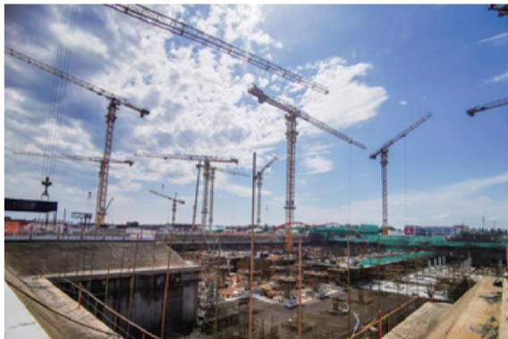
面积 19 万平米,由地上 20 个单体建筑组成,建筑高度 28.2 米,现场塔机按图纸总体呈“吕”字形布局,全部塔机安装均配合项目进度提前完成,目前 17 台塔机已全部检测合格并陆续投入使用。下一步,机施分公司将与对李遂项目协同配合开展塔机管理工作,确保塔机的安全运转,实现了分公司对公司主业的专业支撑,助力公司完成顺义河东地区首个棚改回迁安置房的建设任务。
