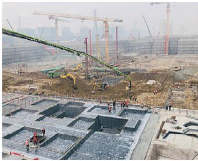
本段筏板厚 600、800 毫米，共浇筑 C40P10 混凝土 361 立方米，浇筑方式为泵送，由一台输送泵施工。为确保混凝土顺利浇筑，项目团队在技术交底、劳务人员安排、原材料供应、机械部署、现场配合部署等方面做足了准备，从浇筑伊始直到结束，生产人员全程现场跟踪指挥，在各部门的密切配合协作下，于 4 月 6 日 12 时，圆满完成浇筑任务，实现本工程筏板浇筑“零”的突破。
