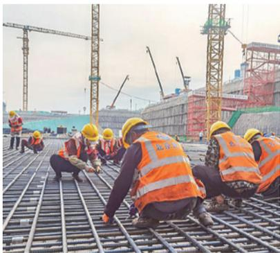
(通讯员 付艳坤 朱耿涛) 东升科技园二期 L24、L20 地块目前均处于地下结构施工。L24 地块已完成 1 万余根混凝土桩的施工任务，现场南北 2 个施工区、33 个流水段正同步开展各项地下基础作业。4 月 4 日，车库（北区 9 段）首段基础筏板钢筋验收合格，首段筏板混凝土开盘。
