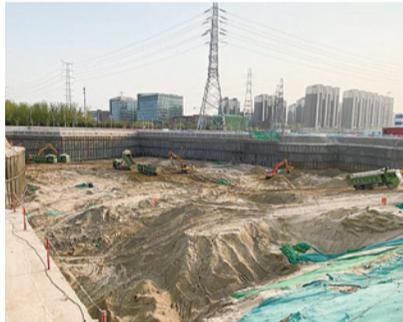
(通讯员 韩贺磊) L20 地块陆续克服了工期紧、基坑土方开挖难度大、外部环境复杂等诸多困难，截至到 4 月 8 日，土方开挖已完成 55.2 万方占比 79.5%，预应力锚杆完成 1568 根占比 62.8%，柱间护完成 6150 平方米占比 45.2%，钢腰梁施工完成 1910 米占比 56.8%，基坑支护各项工艺全力施工进行中，预计一周内南段将交付于施工队地基处理工作面。目前项目团队在全力开展土方施工的同时，全力以赴为后期主体工程施工做准备，多方协调修改讨论施工方案。
