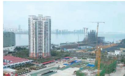
(通讯员 陈泽松) 海南大学桥西教职工居住区三期项目部将于2021年3月1日正式复工，目前正组织低风险地区劳务人员陆续办理返厂手续和新入场员工全员安全教育培训。目前，现场6015型塔吊7台、现场肥槽回填土挖机200型1台均状态良好，现场库存钢筋共计约100吨；施工外用电梯计划12台将于4月1日开始安装；模板及木方材料全部到齐，后期需要更换在补充。项目团队2021年将以省级安全文明施工工地为目标，确保现场重大安全事故为0，主体结构预计8月30日完成(含25层结构封顶)，二次结构预计9月30日完成。
