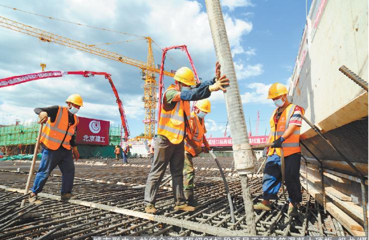
城市副中心站综合交通枢纽01标段项目正在浇筑混凝土顶板。祖戈/摄
