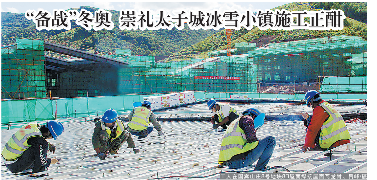
工人在国宾山庄8号地块8B屋面焊接屋面瓦龙骨。吕峰/摄
