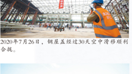
2020年7月26日,钢屋盖经过30天空中滑移顺利合拢。
