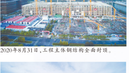
2020年8月31日,工程主体结构全面封顶。
