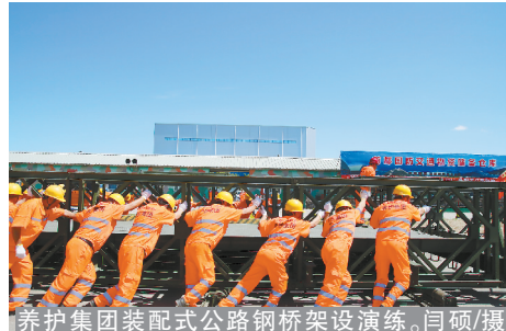
养护集团装配式公路钢桥架设演练。闫硕/摄
