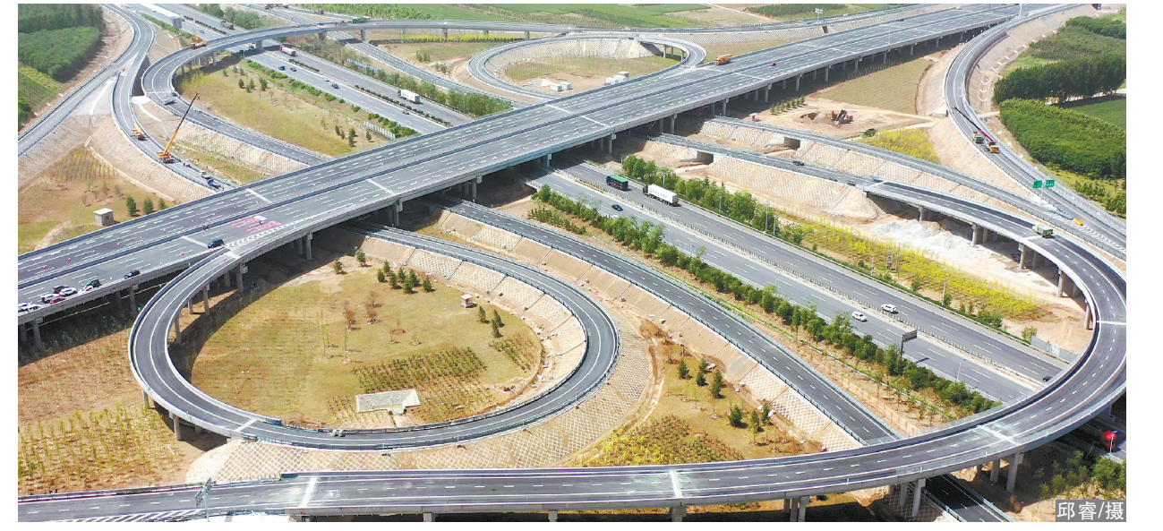
5月29日,荣乌高速新线正式通车运营,北京与雄安新区之间的车程缩短到1个小时。市政路桥总承包一部承建了荣乌高速新线ZT5标段。
