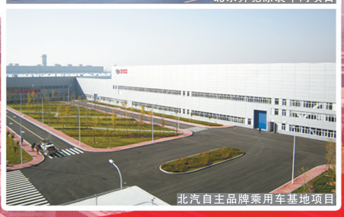
北京奔驰涂装车间项目
