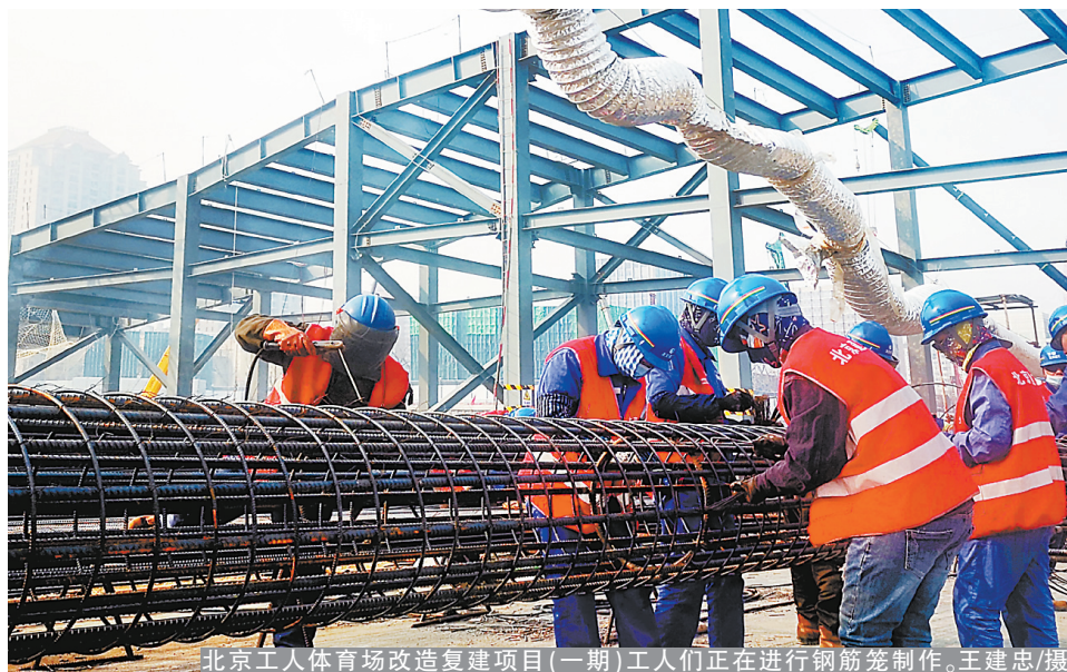
北京工人体育场改造重建项目（一期）工人们正在进行钢筋笼制作。王建忠/摄
