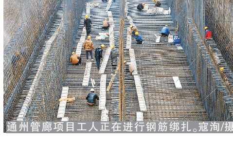
通州管廊项目工人正在进行钢筋绑扎。寇洵/摄
