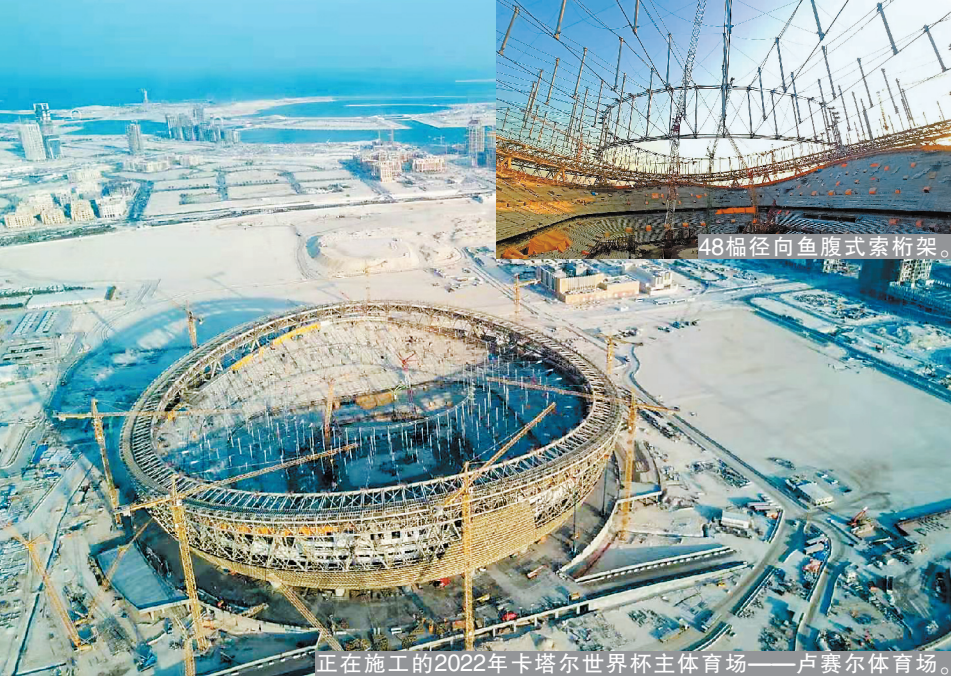
正在施工的2022年卡塔尔世界杯主体育场——卢赛尔体育场。
