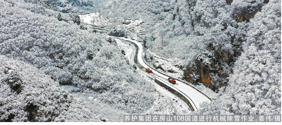
养护集团在房山108国道进行机械除雪作业。姜伟/摄
