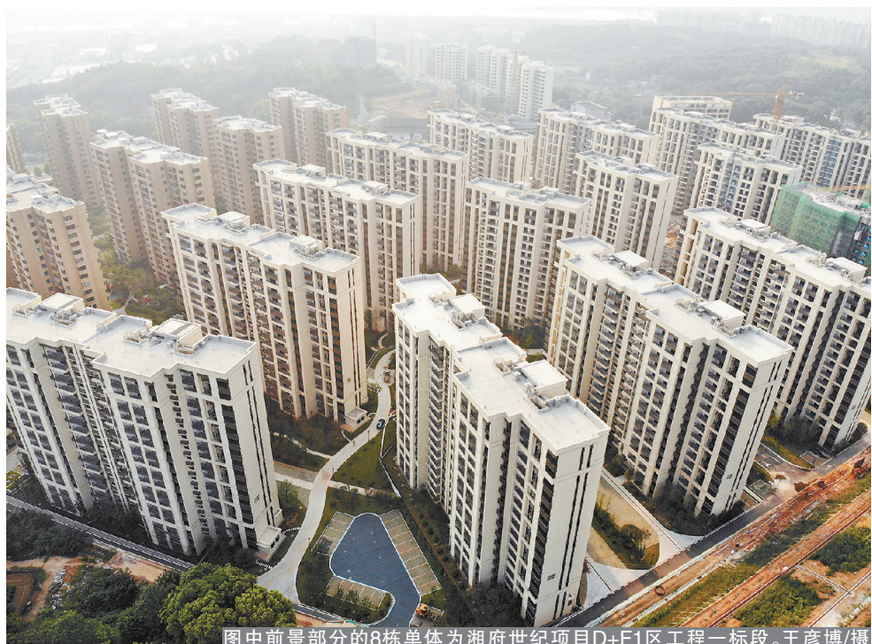
图中前景部分的8栋单体为湘府世纪项目D+F1区工程一标段。王彦博/摄
