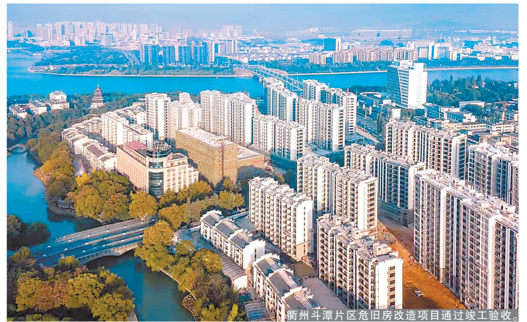
衢州斗潭片区危旧房改造项目通过竣工验收。
